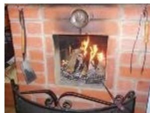
18. Печи, камины и другие отопительные приборы должны иметь установленные нормами противопожарные разделки (отступки) от горючих конструкций, без прогаров и повреждений предтопочный лист размером не менее 0,5 x 0,7 м (на деревянном или другом полу из горючих материалов).
