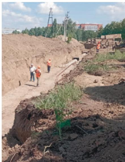
– от ТК133–ТК134 — две трубы диаметром 500 мм с капремонтом камеры ТК134 (за домами № 36 и 37).
